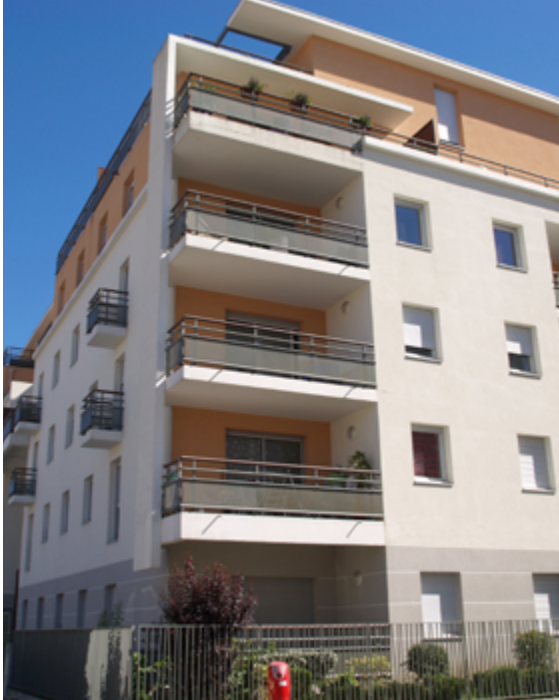
Immeuble Carnot, Saint-Etienne
