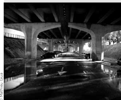
Sous l'autoroute A10.
