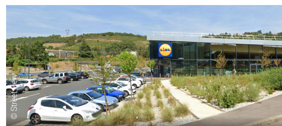
Lidl (Chasse sur Rhône), traitement paysager des abords et bâtiment qualitatif
