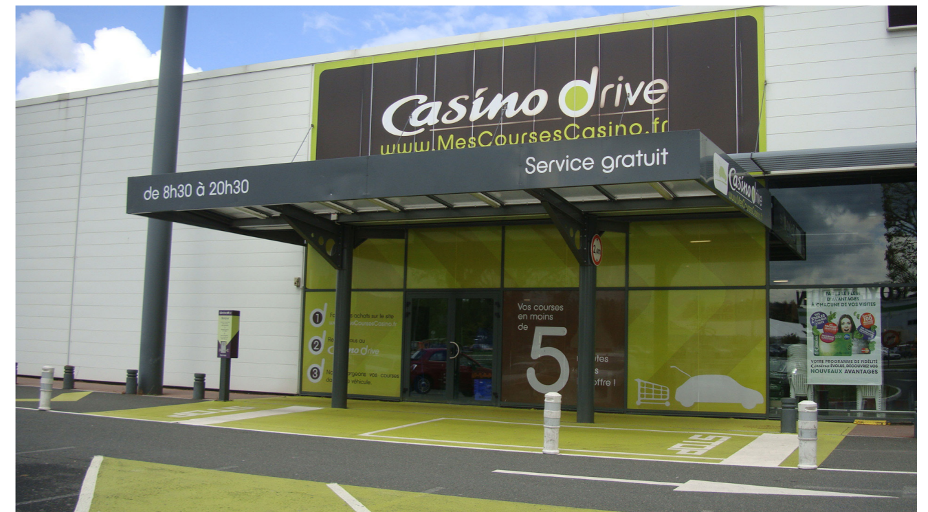
Casino Drive situé au sein de la zone commerciale de Ratarieux à Saint-Priest-en-Jarez (42)
