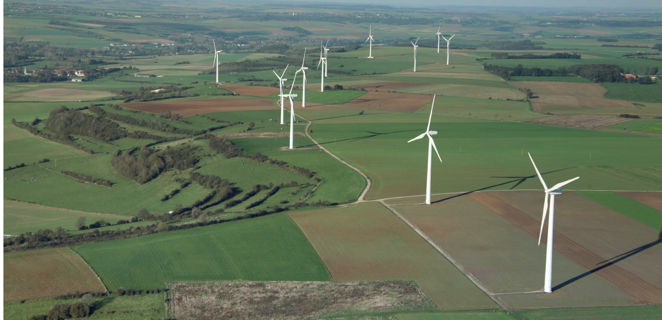
Au sein du Pays de Saint-Omer, la communauté de communes du canton de Fauquembergues a misé sur l'énergie éolienne
