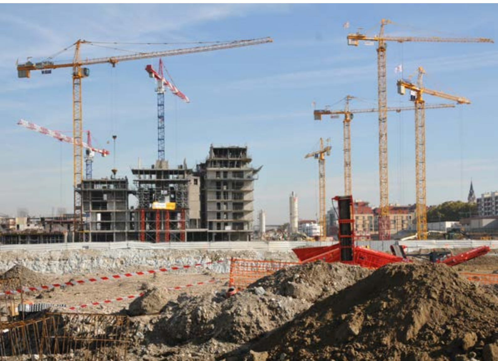
Chantier du confluent, Lyon 2 e
