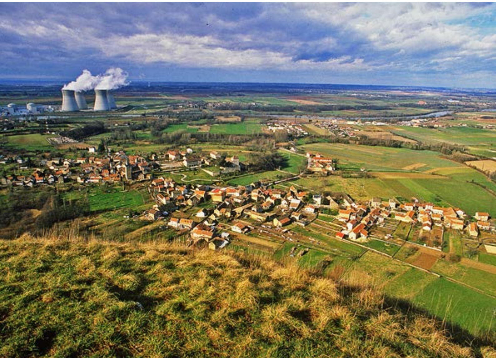
Centrale du Bugey
