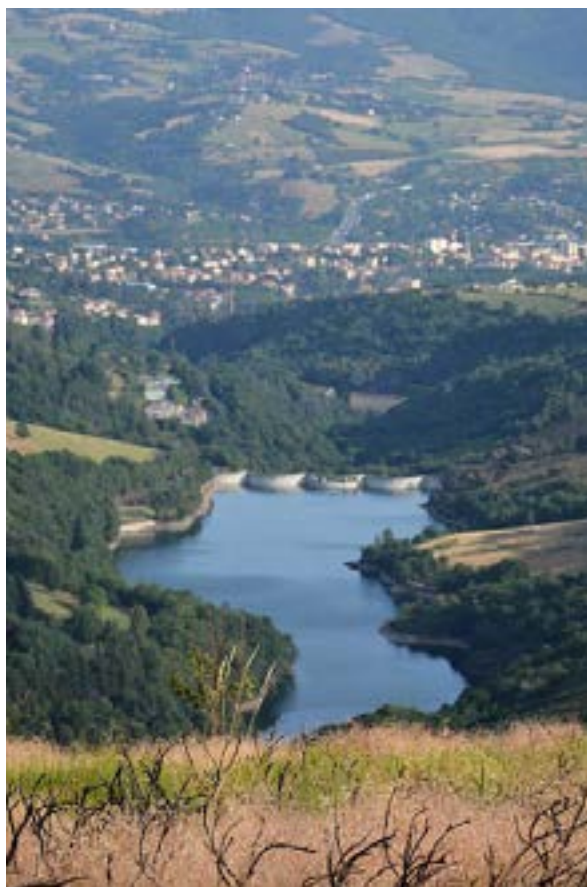
Barrage de Soulage, Saint-Chamond
