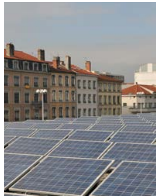
Panneaux Photovoltaïques, Lyon 3
