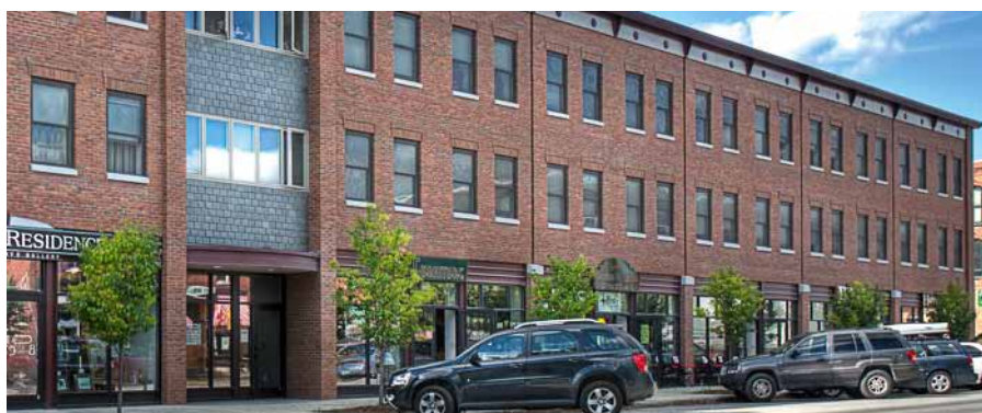
Construction de logement abordable aux États-Unis
