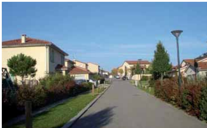
Une voie de desserte de lots dont le profil laisse une part aux espaces verts et au cheminement des piétons.
