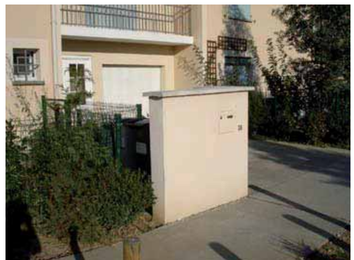
Corbas - 69 Un muret en "L" de la même hauteur que les clôtures abrite les coffrets électriques et dissimule les poubelles depuis la rue.
