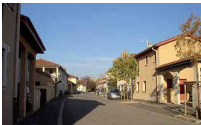
Le Clos des Éparviers - Solaize - 69
