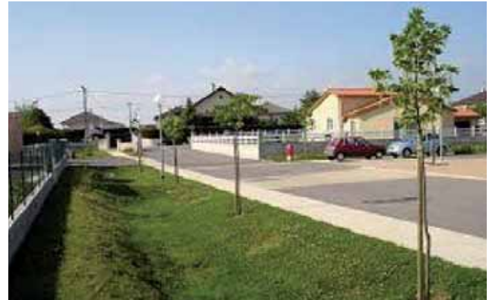
Des fossés pour stocker les eaux de pluie.
