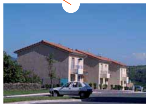
Des maisons mitoyennes au contact du centre.
