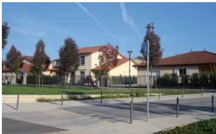
Une section de voirie traitée en voie traversante (Solaize- Clos des Éparviers - 69).
