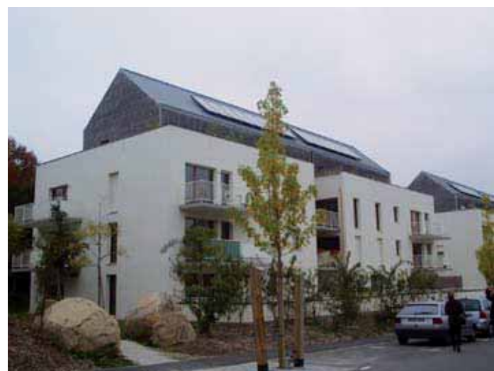
Des panneaux solaires intégrés à l'architecture des bâtiments.
