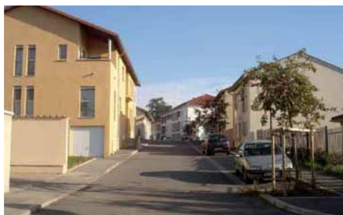
De petits immeubles collectifs en contiguïté avec le centre-bourg.
