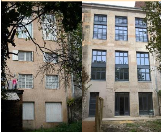
LIVRÉ FIN 2016 MAÎTRE D'OUVRAGE : EPA DE SAINT-ÉTIENNE MAÎTRISE D'OEUVRE : F. BUSQUET AVANT APRÈS
