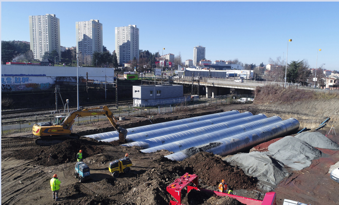
Installation des bassins enterrés sous l'esplanade Nord en 2019 ©Epase – F. Caterin
