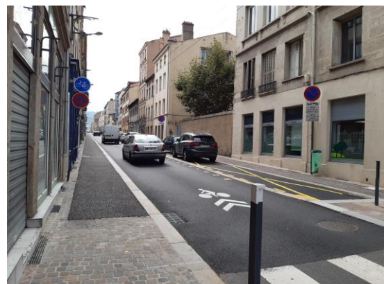
Section de la 2 e tranche de requalification de la rue A. Durafour, en 2021. (photo epures)
