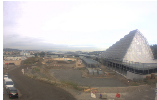
Photo d'avancement des travaux du projet STEEL, 10 septembre 2019
