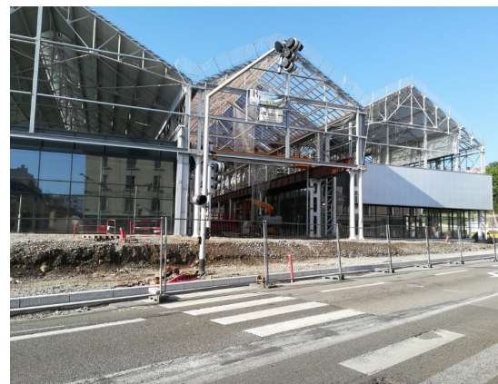
Ancienne friche de Novaciéries, en cours de réhabilitation sur cette photo. Aujourd'hui finalisée. Saint-Chamond (42), 2018
