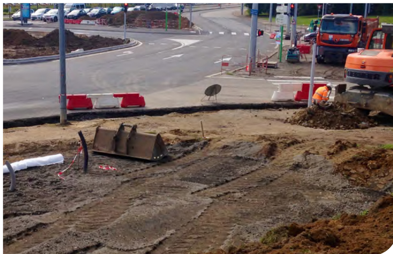
Travaux de désimpermeabilisation, Métropole du Grand Nancy / © C. Schwartz. Source : Désimpermeabiliser les villes, guide opérationnel pour (re)découvrir les sols urbains, Plante&Cité, décembre 2024
