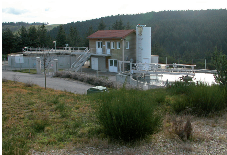
Station d'épuration Saint-Genest-Malifaux
