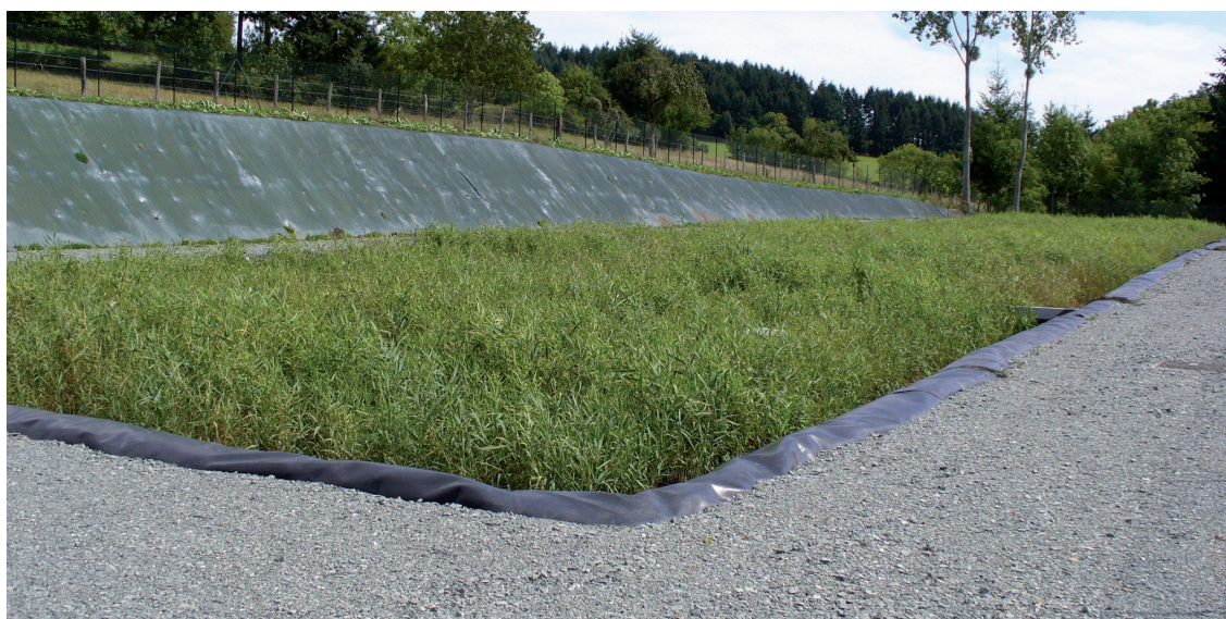
Filtre planté de roseaux, Crémeaux
