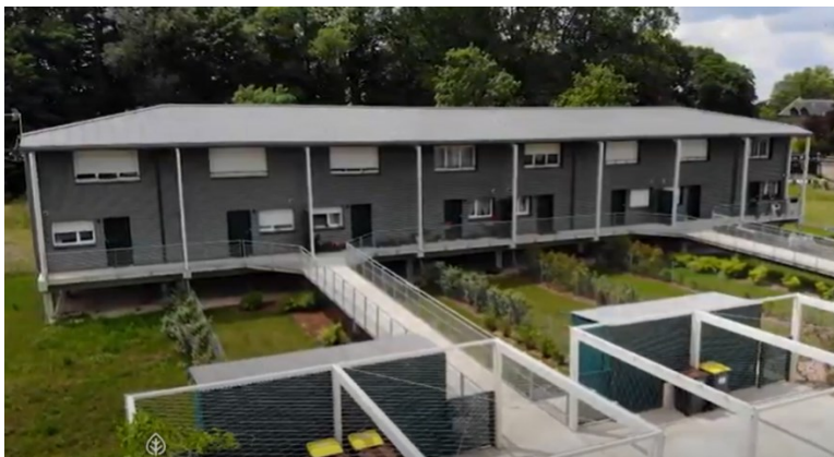
Romorantin (41) Des logements construits sur pilotis en zone inondable et économes en énergie 23
