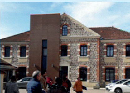
Vue arrière du bâtiment avec ascenseur
