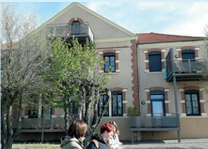
Vue avant, ajout de balcons
