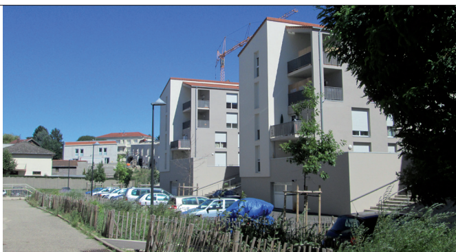
Collectifs créés au pied de la cité (opération n°1).
