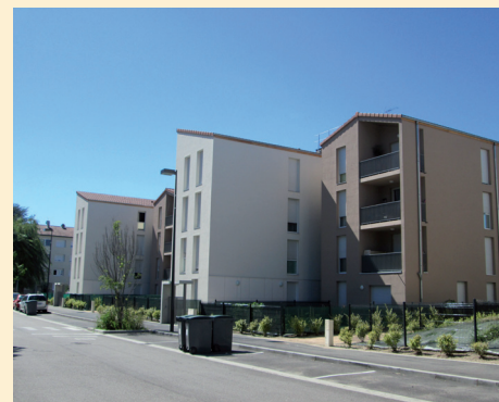
Les logements collectifs de l'opération n°1.
