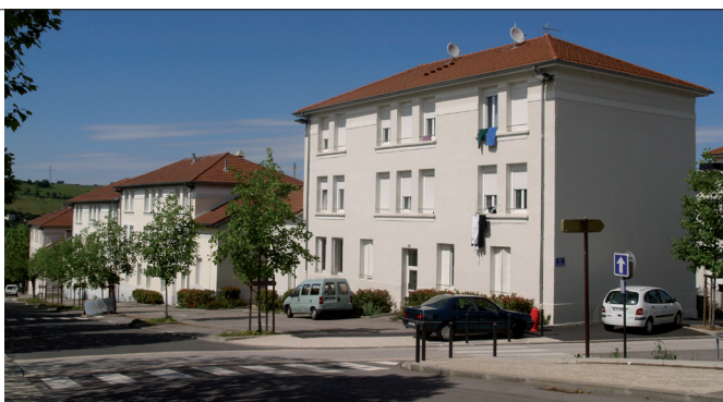
Immeubles de la cité réhabilités.
