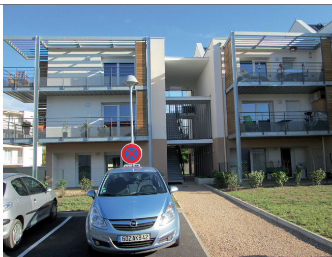
Logements collectifs avec balcons (en applique sur la façade) et coursives pour accéder aux logements (ensemble n°2).
