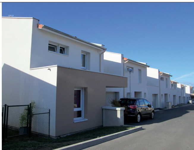
Maisons individuelles en bande avec entrée au nord (ensemble n°1).
