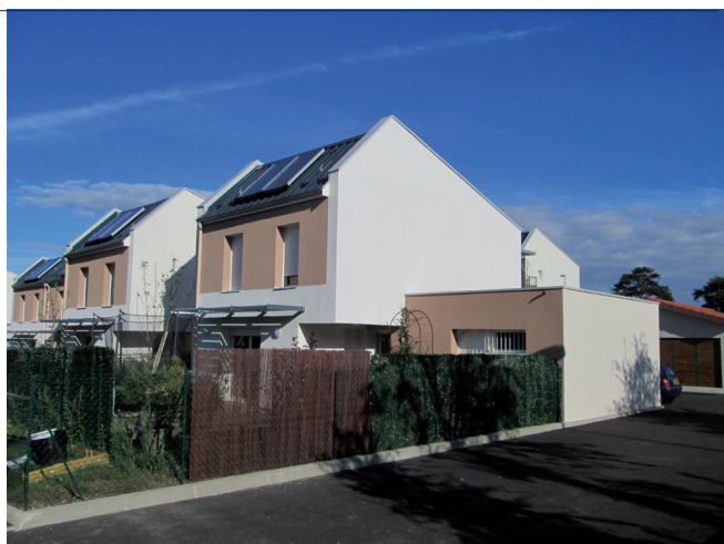
Maisons individuelles ouvertes sur les jardins au sud avec toitures en bac acier recouvertes de panneaux solaires (ensemble n°1).
