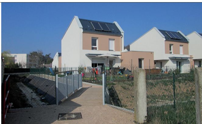
Chemin piéton longeant le bassin de rétention d'eau pluviale.
