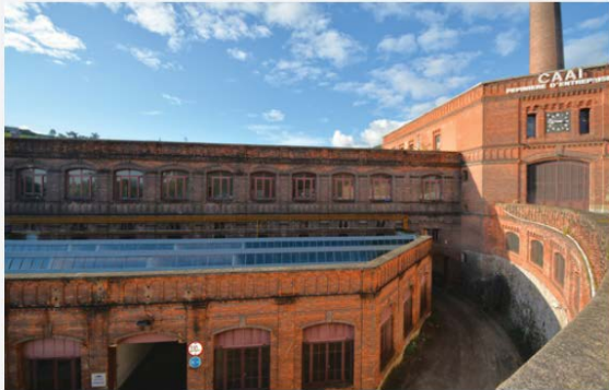
Usine Gillet implantée dans la vallée de Moulin Combat, aux abords du Gier à Saint-Chamond (classé monument historique MH) - © epures
